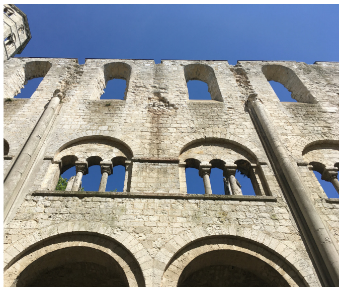
Mur nord de la nef de Notre-Dame, XI e siècle.
